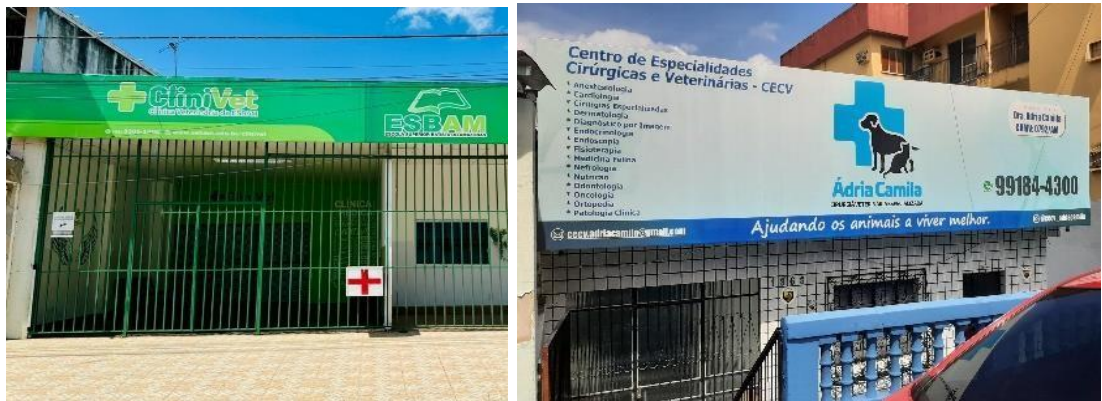
Figura 2A – Fachada da Clinivet. Fonte: Aquino, 2024. 2B- Fachada do CECV. Fonte: Iannuzzi, 2024
